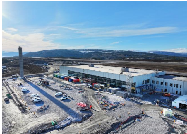
Bygging av ny flyplass i Mo i Rana. Foto: Hedda Hiller/Avinor
